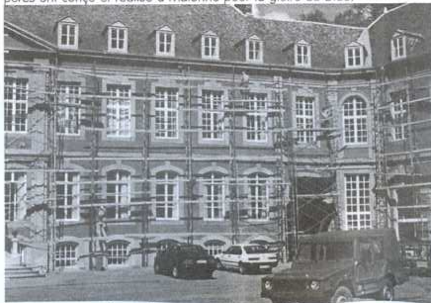
La cour d'honneur en avril: un fameux chantier!
